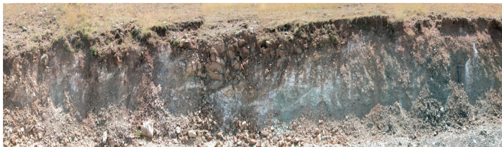
Figura 6.22 - Sbancamento stradale con affioramento di amianto naturale
