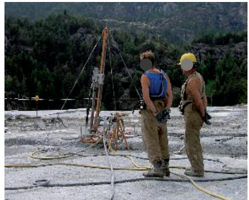
Figura 6.1 - Perforazione della bancata
