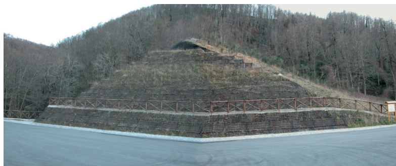
Figura 6.11 - Cava di prestito dopo interventi di ripristino
