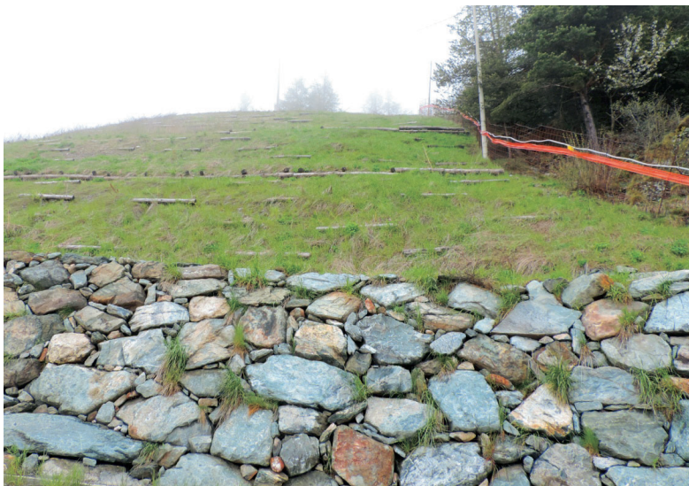
Figura 6.13 - Interventi stabilizzanti del versante
