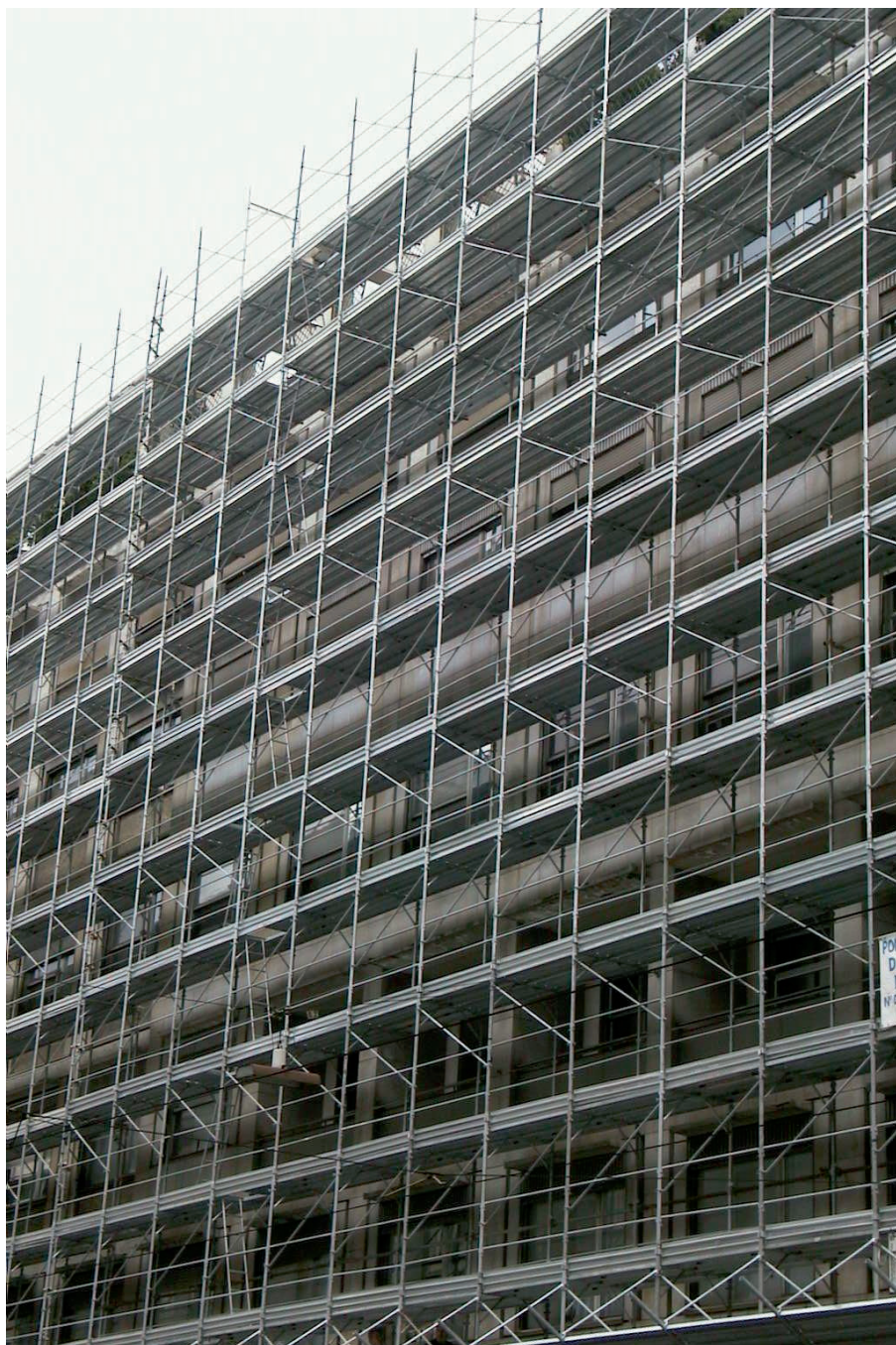
Figura 1.1: Ponteggio di facciata (Fonte: Eurotempo)
