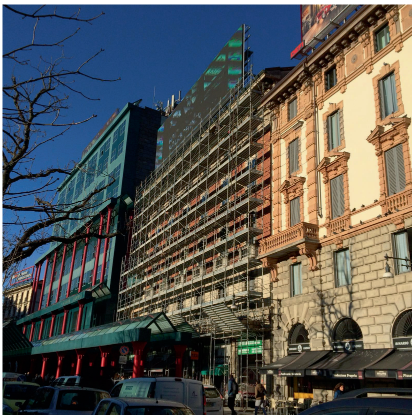
Figura 4.1.1-2: Ponteggio di facciata (Fonte: Eurotempo)
