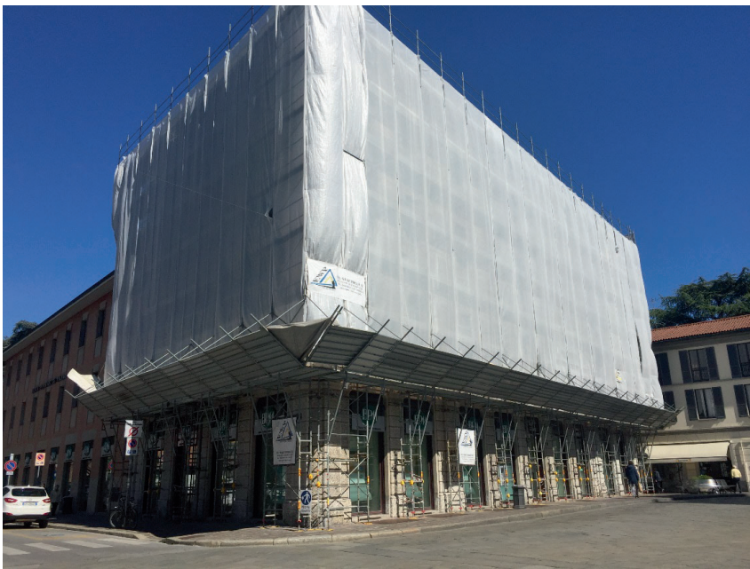
Figura 5.9-1: Ponteggio rivestito con teli (Fonte: Eurotempo)
